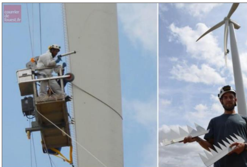
INSTALLATION DE SERRATIONS SUR LE PARC EOLIEN DE BORALEX DE COULONGES, LE COURRIER DE L'OUEST, 2016
